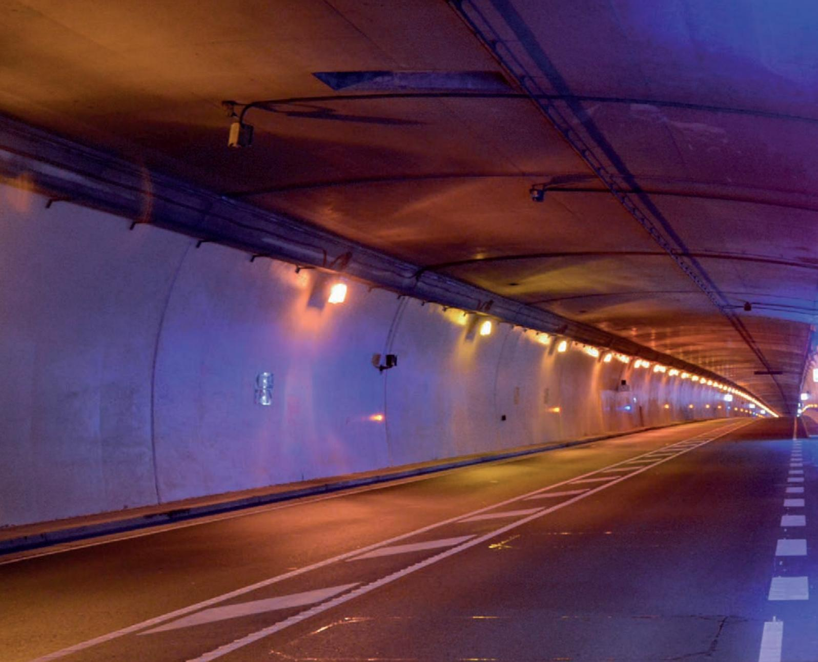
frentes intermedios y, actualmente, sirve como vía de evacuación, estando unidos ambos túneles mediante 17 galerías transversales.
