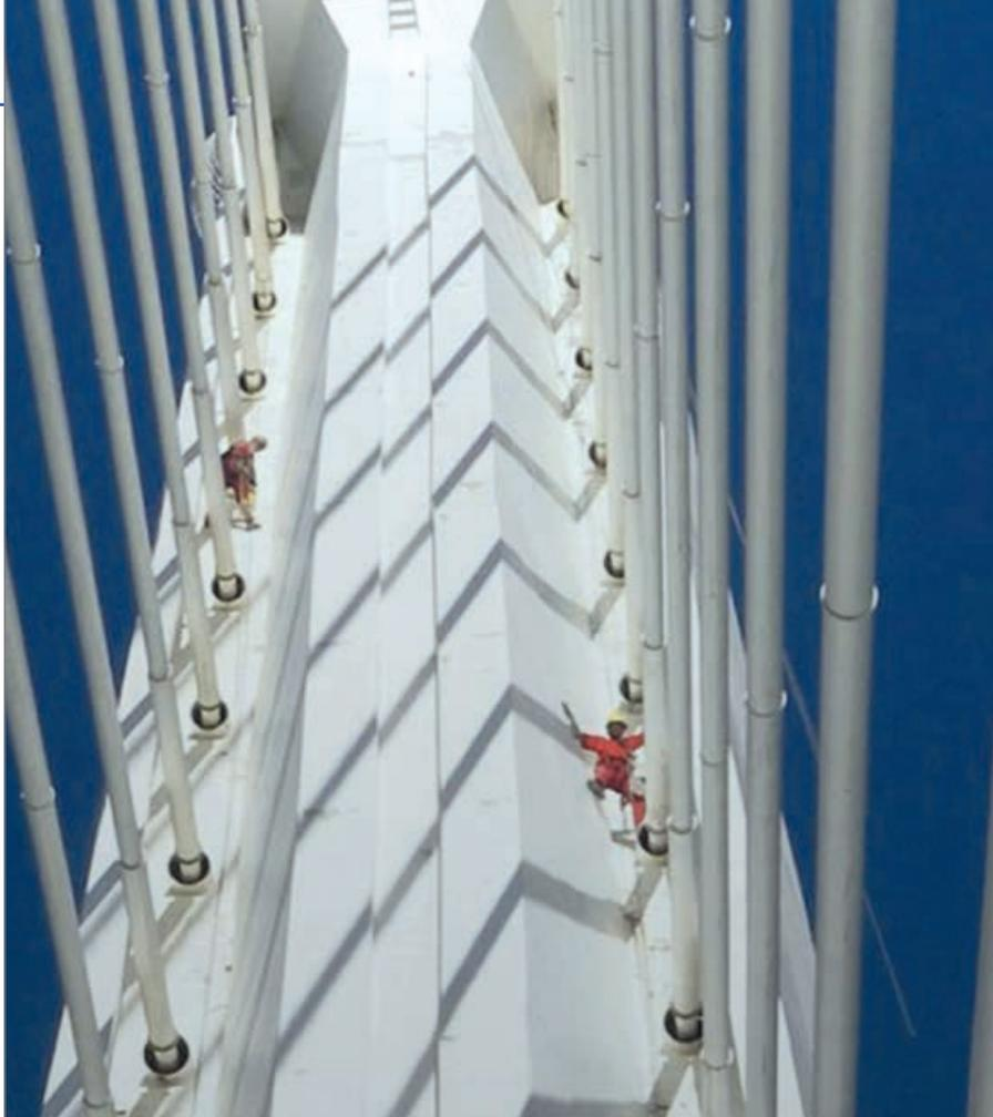
Foto 1. Inspección in situ de tirantes. Puente del Alamillo. Fuente: Azul Construccion Repair, S.A.
